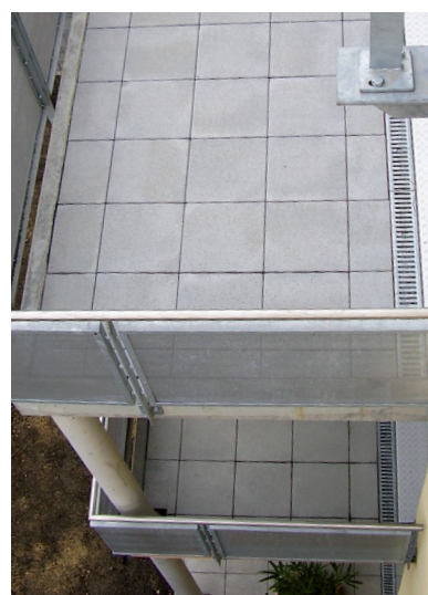
Rigolă cu pereți perforați cu colectare apei de pe membrana hidroizolantă, finisaj permeabil: balcon cu ACO Self® Highline
