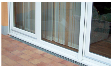
Rigolă etanșă cu racord la sistemul de colectare: fațadă cu ACO Self® Hexaline
