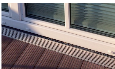
Rigolă cu pereți perforați, fără racord la evacuare: terasă cu ACO Self® Highline
