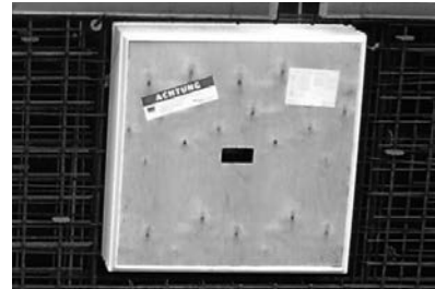
Plăcile de rigidizare din lemn trebuie să rămână atașate în tot timpul fazei de instalare.
