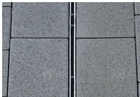
Exemplu de instalare grătar fantă
