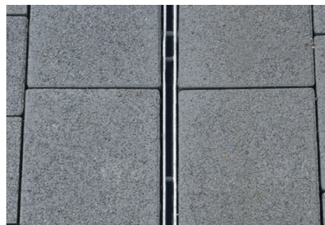
Exemplu de instalare grătar fantă
